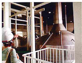
仕込み釜の様子
